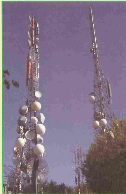
▲ Un ripetitore televisivo analogico: se siamo oscurati da un ostacolo anche non naturale, la nostra ricezione risulta difficoltosa.
